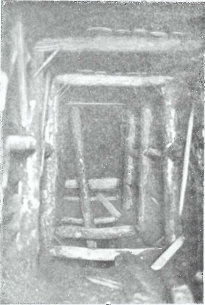
სურ. ნ. გვირაბი არხის ზედა ნაწილთან (დასაწყისთან). გვირაბი გამაგრებულია და შემცირებული ჩვენ მიერ.
