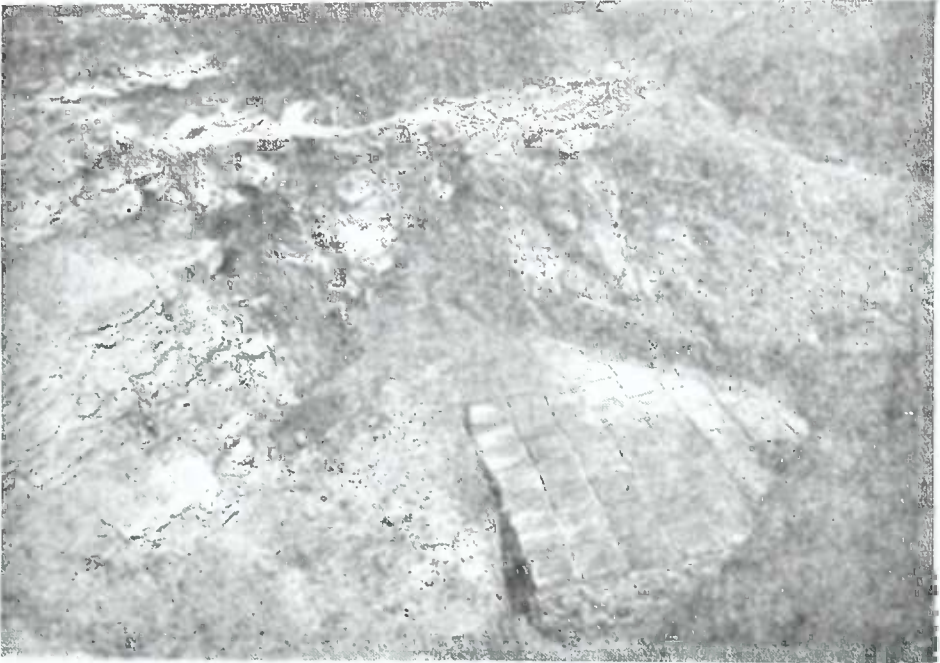
სურ. 72. ქვემო-აბანო. ოთახი A: წახნაგზე დაყენებული აგურების წყობა (მარცხნივ) და ზღვე (მარჯვნივ).
