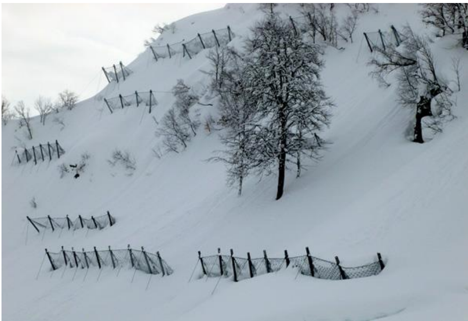
სურ. 6.5. ზვავის შემაკავებელი ალუმინის ბადე
