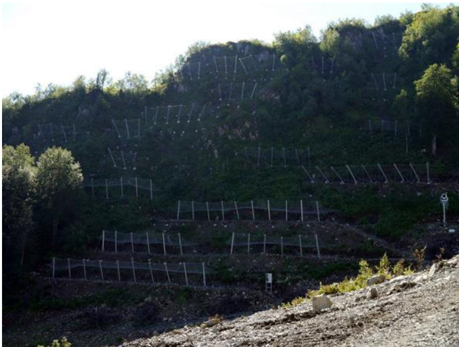
სურ. 6.6. ზვავის შემაკავებელი ნეილონის ბადე
