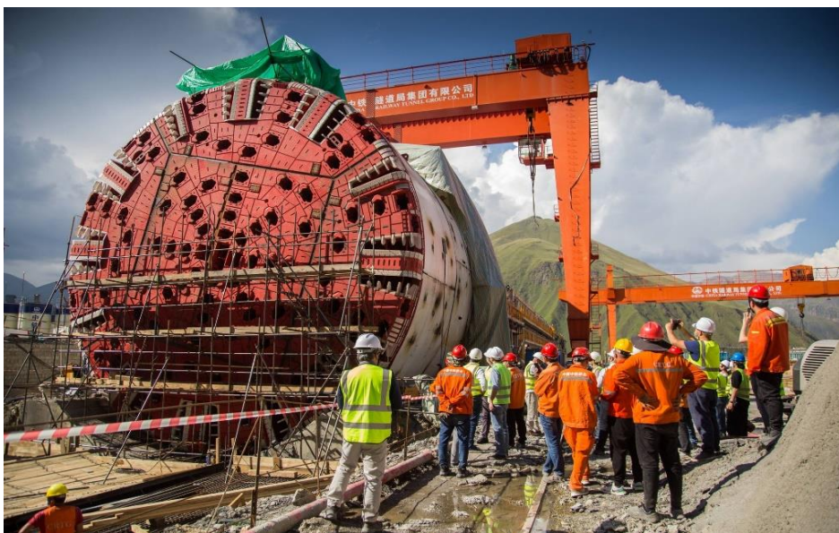
ნახ. 1.3.9. გვირაბის მშენებლობისთვის გამოყენებული ბურდი ( https://kveshetikobiroad.ge/ )
