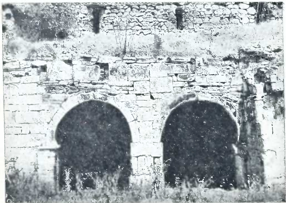
Рис. 40. Двойная арка входа (по фото 1916 года).
