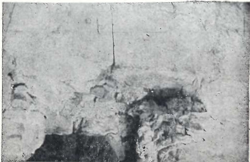
Рис. 14. Верхняя часть проломанной в северный придел двери.
