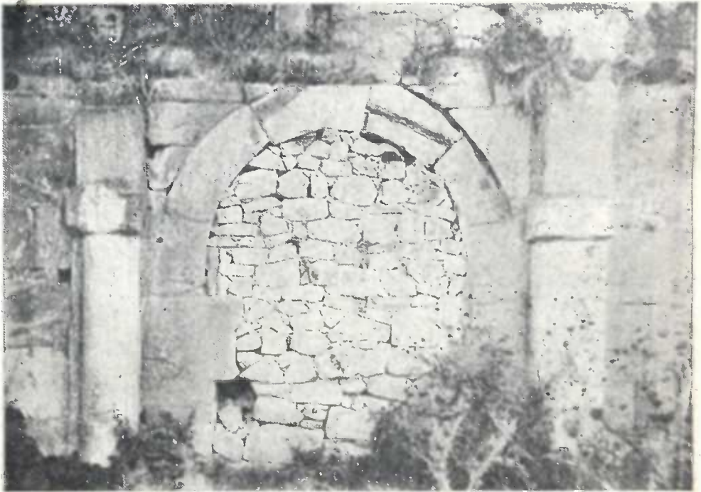
Рис. 22. Заложенная первая дверь с люнетом в северной галлерее до раскопок и раскрытия.
