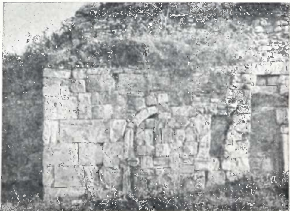
Рис. 44. Уцелевшая часть северной галлерей с заложенным проемом (по фото 1920 г.).
