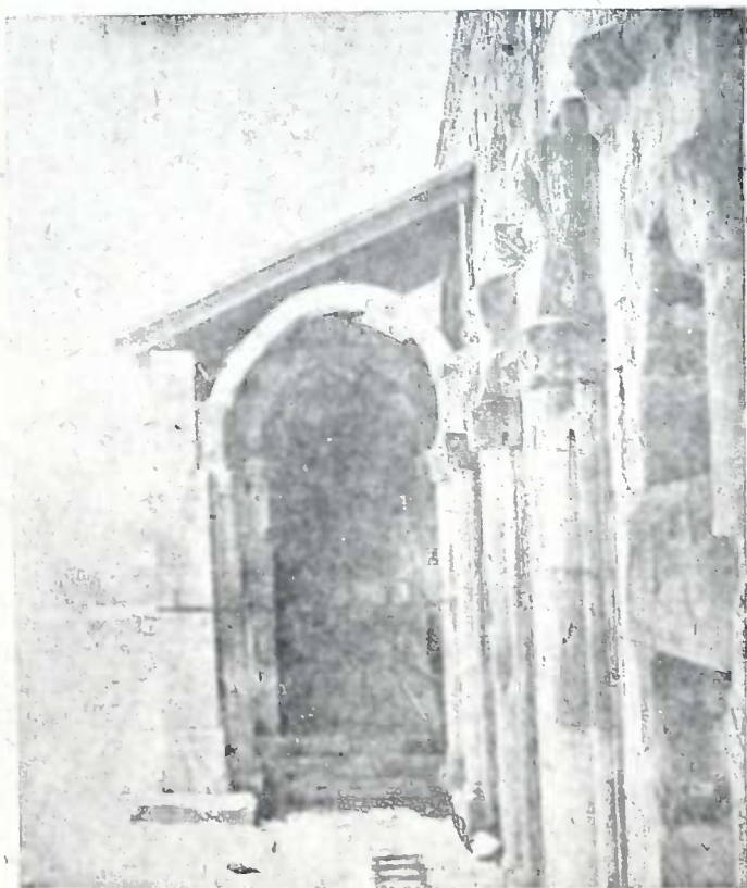
Рис. 19. Раскрытая в 1939 г. арка, перед конхой северной галереи.
