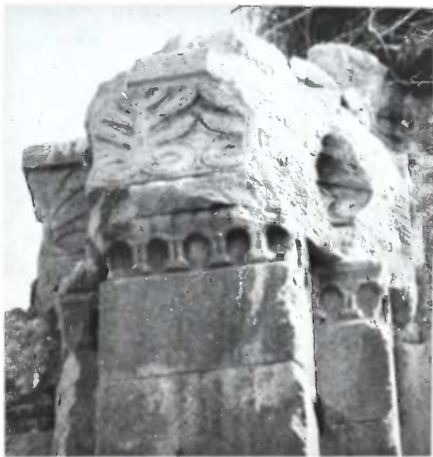
Fig. 3. Chapiteau-imposte. Mur Nord.
